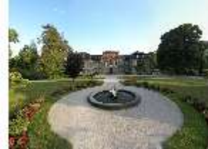
BayFa.I, Nordfassade, DI017099, BSV-
