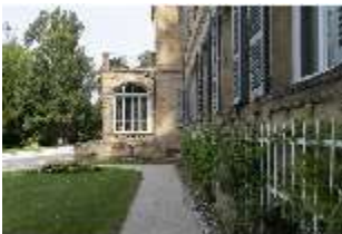
BayFa.I, Südfassade, Eingangsrisalit, DI017117, BSV-
