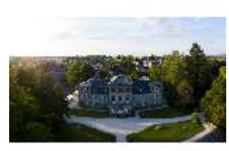
BayFa.I, Südfassade, DI017108, BSV-
