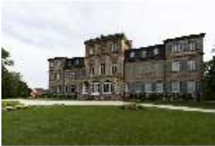
BayFa.I, Südfassade, DI017114, BSV-
