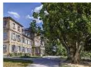
BayFa.I, Südfassade, DI002699, BSV
