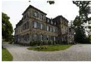
BayFa.I, Südfassade, DI017111, BSV-
