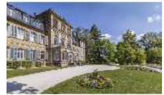
BayFa.V, Schlossterrasse mit Südfassade, DI002697, BSV
