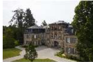
BayFa.I, Nordfassade, DI017102, BSV-
