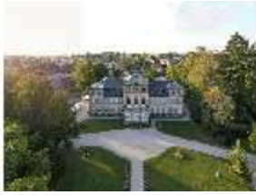
BayFa.I, Südfassade, DI017101, BSV-
