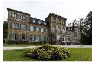
BayFa.I, Südfassade, DI017112, BSV-
