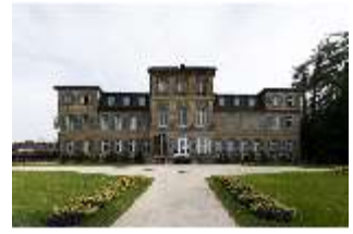
BayFa.I, Südfassade, DI017113, BSV-
