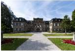
BayFa.I, Nordfassade, DI017136, BSV-
