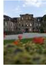
BayFa.I, Nordfassade, DI017160, BSV-
