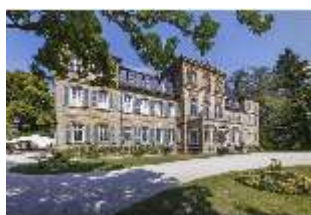
BayFa.I, Südfassade, DI002698, BSV
