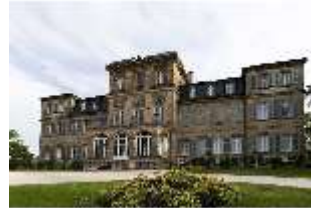
BayFa.I, Südfassade, DI017116, BSV-
