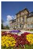
BayFa.I, Nordfassade und Blumenrabatten der Schlossterrasse, DI002558, BSV
