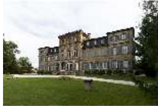
BayFa.I, Südfassade, DI017115, BSV-
