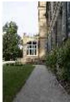
BayFa.I, Südfassade, Eingangsrisalit, DI017118, BSV-
