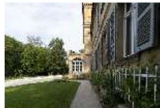
BayFa.I, Südfassade, Eingangsrisalit, DI017119, BSV-
