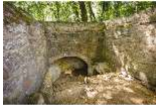
BayFa.V, Ruine der ehem. Strohütte, DI002701, BSV
