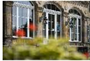
BayFa.I, Fenster Südfassade, DI017142, BSV-
